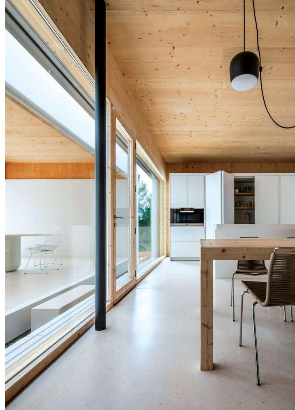
Para la materialización se ha optado por sistemas constructivos en seco, con una presencia generalizada de la madera. La estructura de paneles de madera contralaminada (CLT) se ha dejado a la vista en el interior, concentrándose en un solo elemento constructivo estructura, cerramiento y acabado. Una actitud de sinceridad constructiva, pero que a la vez genera confort y calidez ambiental.
