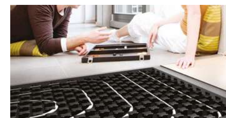
Sistemas de calefacción
