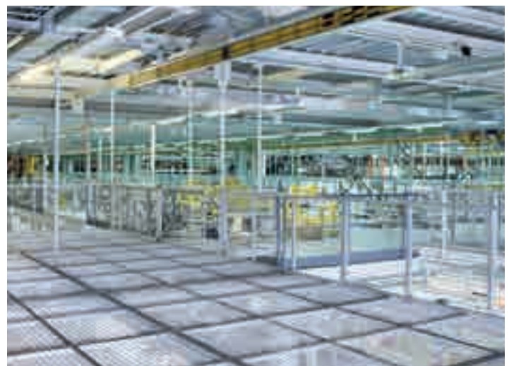
PANELES DE PROTECCIÓN ANTICAÍDAS
